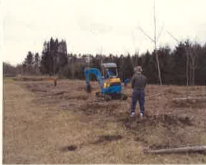
樹木移設作業
