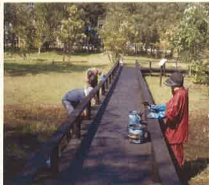
ポロト地区木道防腐処理
