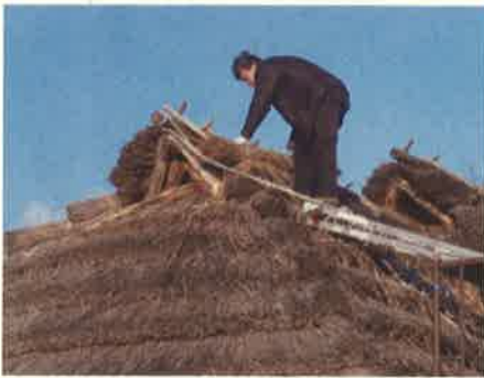
1号チセ屋根修復
